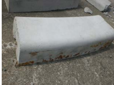
塗布後の型枠で製造した製品（錆なし）
