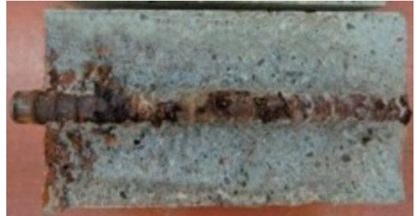
無塗布 鉄筋に腐食が見られる
