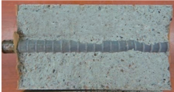
アクアシール1400AR 鉄筋に腐食なし
