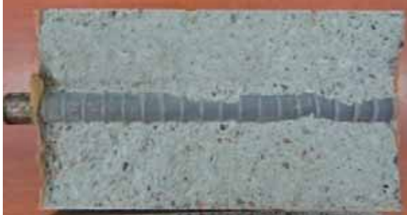
アクアシールド1400AR 鉄筋に腐食なし
