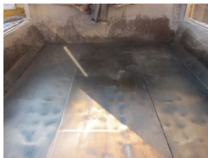
ハイブリット舗装(改質Ⅱ型)荷下ろし後
