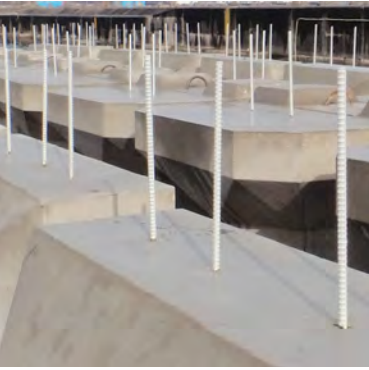
グレー色施工例
