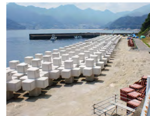
熊野市消波ブロック製作現場
