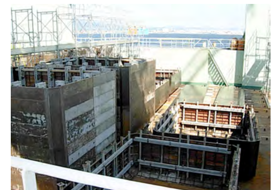
函館港弁天地区岸壁ケーソン製作現場
