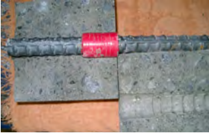
付着応力度測定後の破断面
