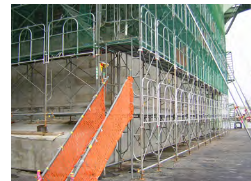
釧路西港ケーソン製作現場
