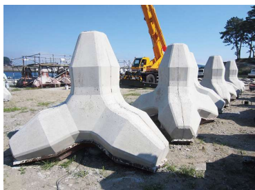
陸前高田市 / 消波ブロック製作現場
