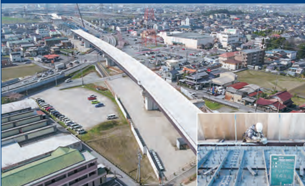
中部地整：赤坂北第1高架橋（岐阜県大垣市）2017年
