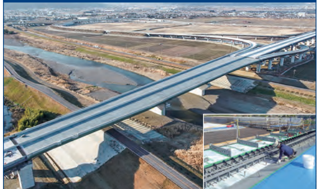
中部地整：牧田川橋内回り（岐阜県養老町）2016年
