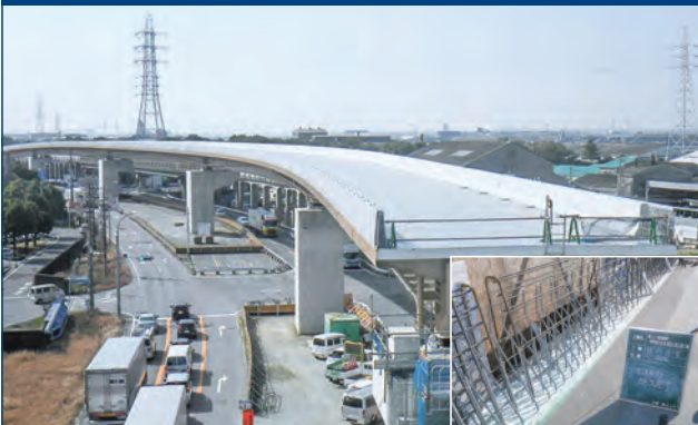
愛知県：高浜高架橋（愛知県高浜市）2016年
