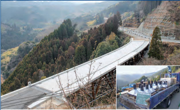
大分県：水落谷橋（上詰5号橋、大分県大分市）2014年
