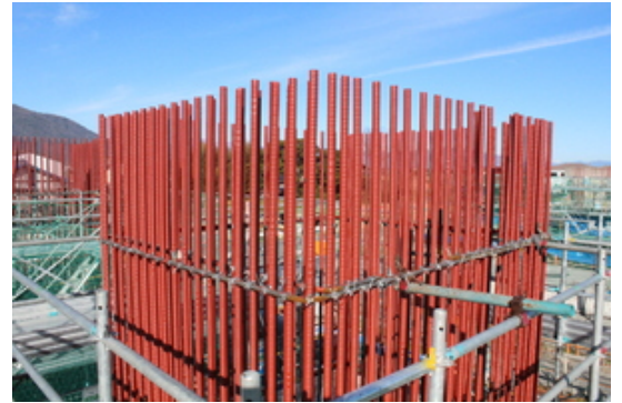
東海環状自動車道の橋脚工事で採用された信越産業の塗布剤「レジコートEP（赤さび色）」
